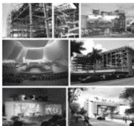
Рисунок 3 - Строительство нового здания американской высшей музыкальной школы
